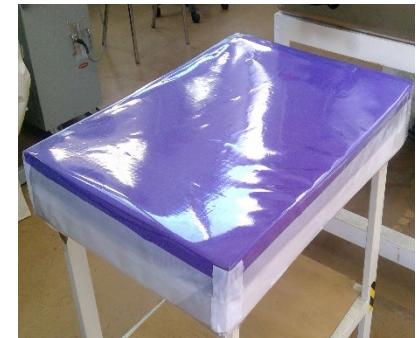
養生材をPVCシートで被う
